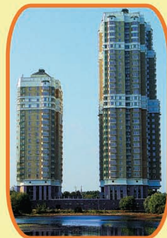
Высотный комплекс зданий на проспекте Вернадского 899 свай \varnothing 300 мм L=21 м 425 свай \varnothing 300 мм L=19 м нагрузка 150 т. на сваю
