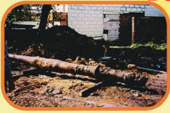
Le premier pieu impulsionnel fabriqué en Allemagne
