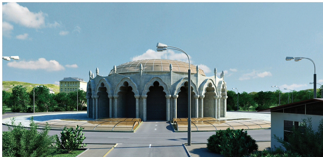
Installations d'épuration « SNE-POSEIDON-50 000K » de capacité 50 000 m 3 /jour
