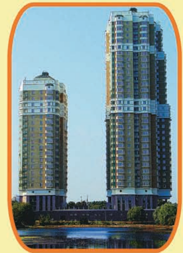
Le complexe des gratte-ciels Avenue Vernadskogo – 899 pieux d=300mm, L= 21 m; 425 pieux d=300 mm, L=19 m; charge - 150 tonne par pieu
